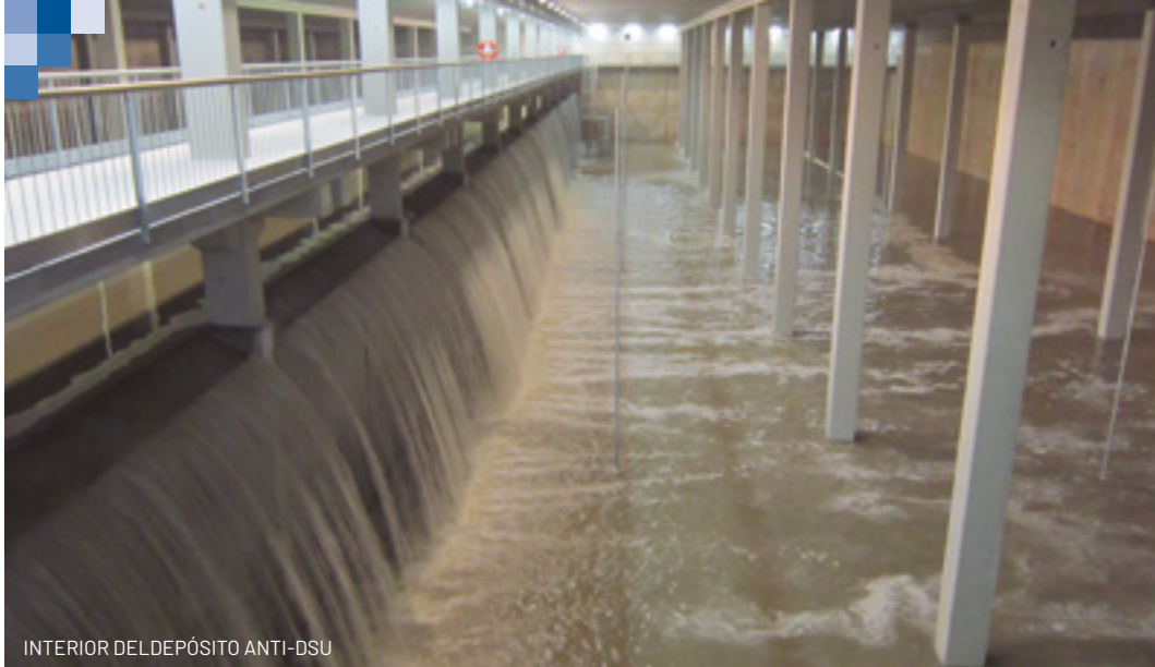
INTERIOR DEL DEPÓSITO ANTI-DSU
