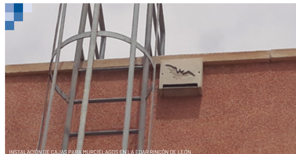
INSTALACIÓN DE CAJAS PARA MURCIÉLAGOS EN LA EDAR RINCÓN DE LEÓN
