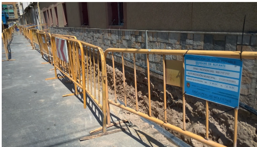
Foto 11: Señalización de zanja en durante ejecución de obra en Los Ángeles, Fase II.
