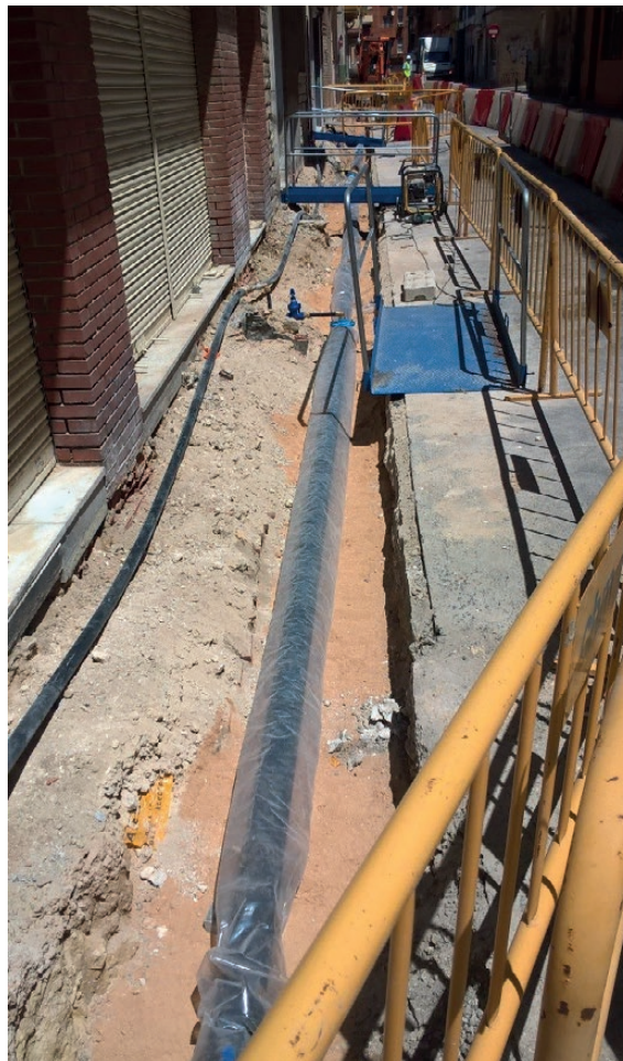
Foto 10: Instalación de tuberías en acera en zona Palmeretes.
