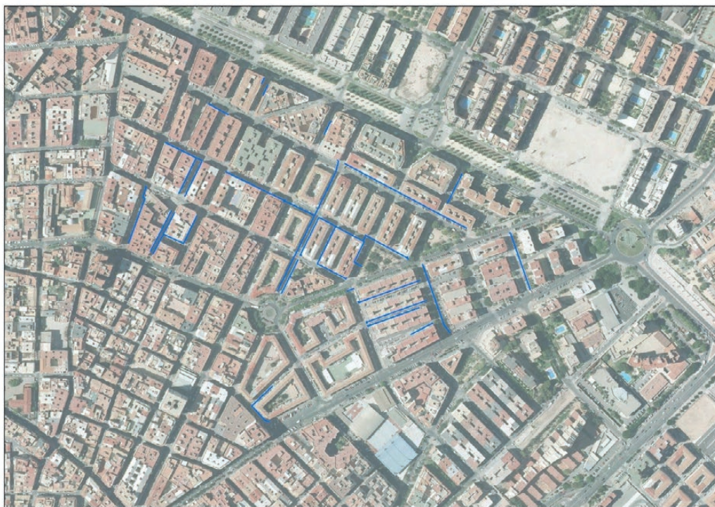
Foto 2: Trazado red agua potable Plaza Manila.
