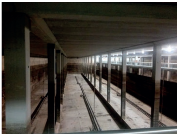
Interior del depósito anti-DSU
