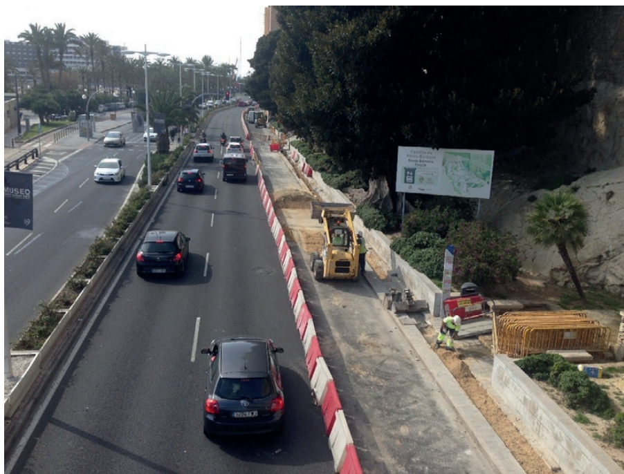
Foto 12: Canalización agua potable C/ Jovellanos.
